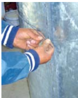
Figura 43. Amarrar el cuerpo del cilindro.
