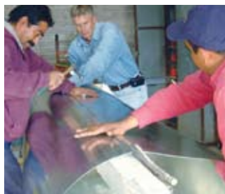
Figura 27. Ensamblar sobre la viga y en el centro con ayuda.
