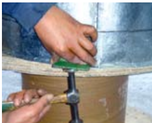
Figura 50. Asentar antes de soldar.
