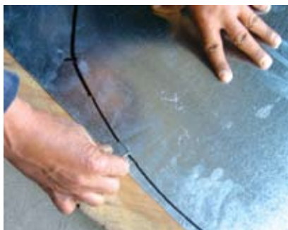
Figura 46. Marcar la pestaña con el gramil.
