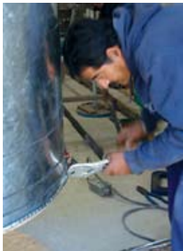
Figura 47. Colocar pinzas para que no se mueva.
