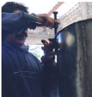
Figura 42. Asentar con base firme para que quede plana.
