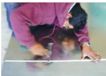
Figura 23. Verificar con el martillo que las láminas hayan embonado perfectamente.
