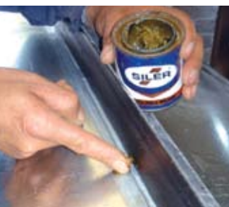
Figura 35. Aplicar pasta para que la lámina se adhiera.
