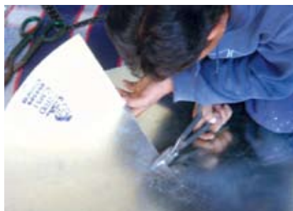
Figura 54. Cortar la boca de entrada del cono.
