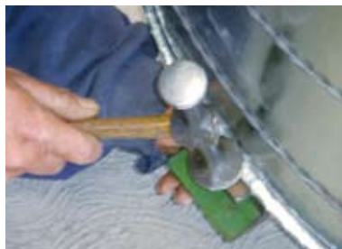
Figura 75. Asentar las pestañas, una a una, después de haberlas cortado.
