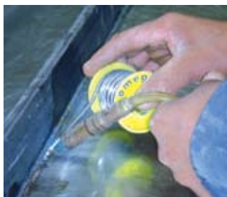
Figura 37. Aplicar la soldadura sin que queden huecos.
