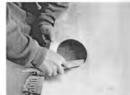
Figura 20. Asiente el borde Figura 21. Lime la orilla
