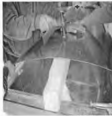
Figura 28. Asiente extremos y centro primero para asegurar, luego el resto.
