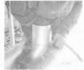
Figura 77. Doble las pestaña para que no se lastime. que están por dentro.
