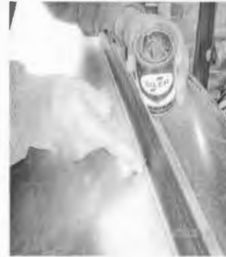
Fig. 35. Aplicar pasta para que pegue la soldadura.
