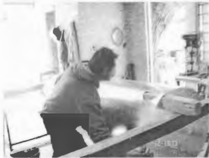
Figura 38. Girar el cilindro para soldar la siguiente hoja.
