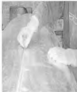
Fig. 34. Lijar la superficie para quitar el galvanizado
