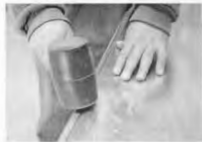
Figura 11. Aplanar el doblado
