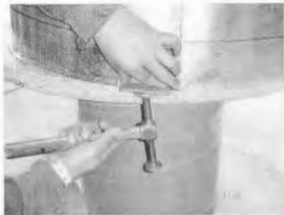
Figura 50. Asentando para que este lista para soldar.
