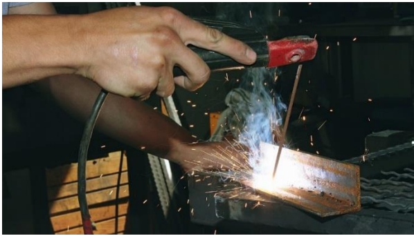
Figure 4: soudure à l'arc
