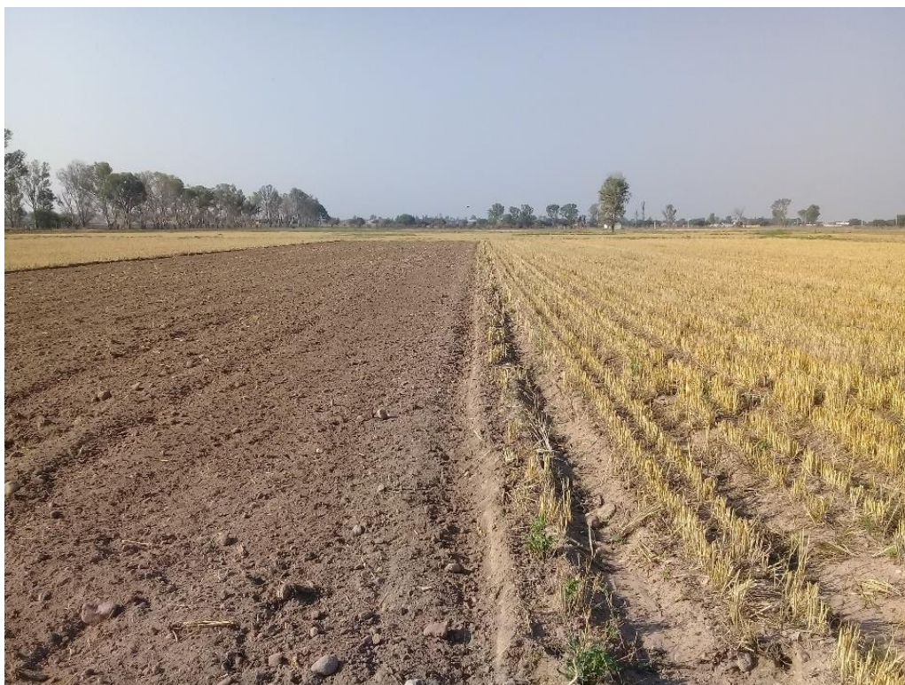
Vista de la plataforma, preparación de terreno, 22 de mayo 2018.
